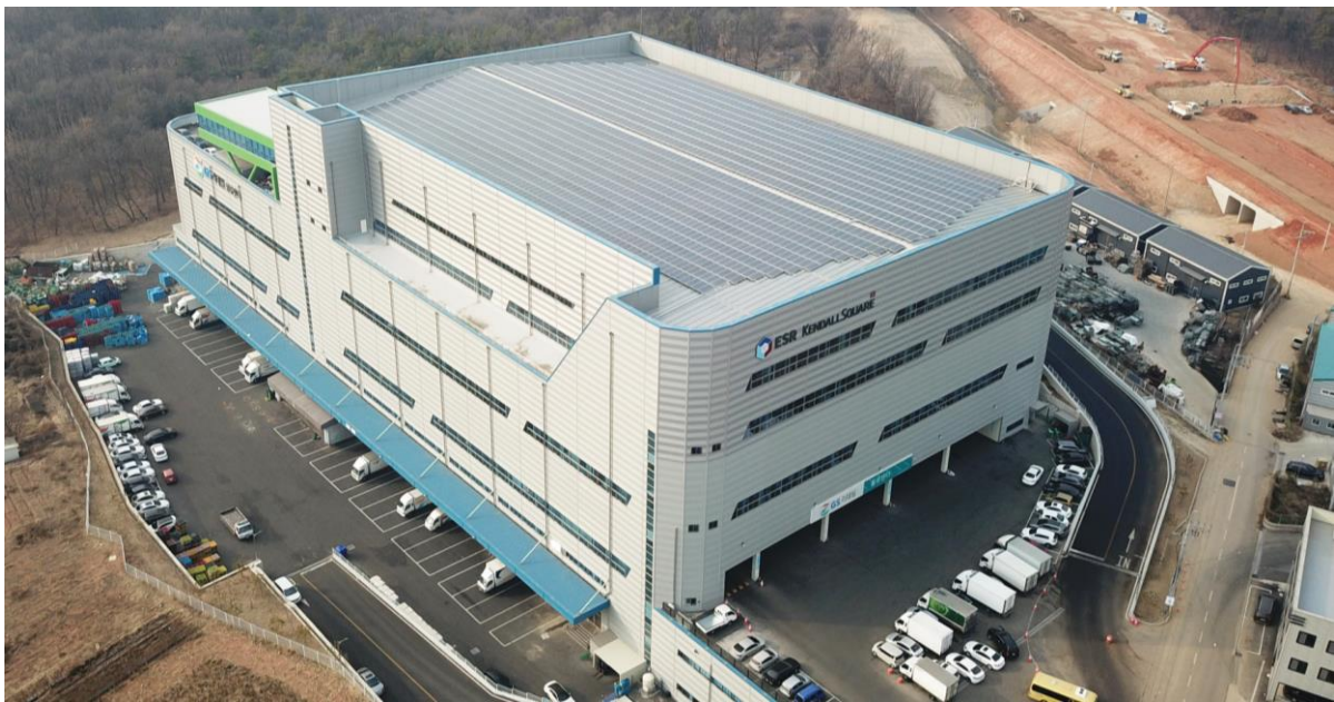
Ilsan Distribution Centre
